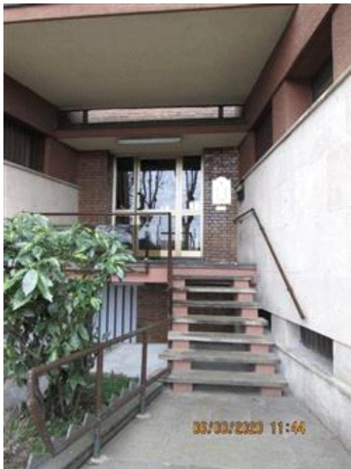
ingresso al fabbricato n. 8
